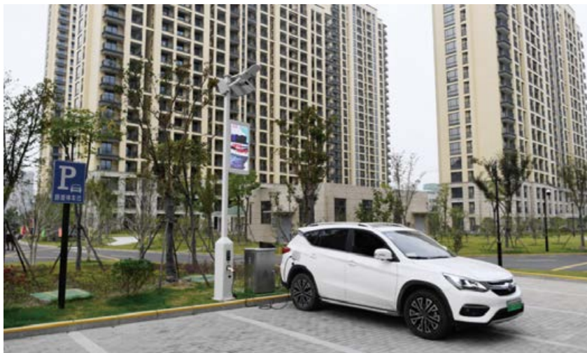
2019 年 10 月 23 日，一辆电动汽车停在杭州德慧公寓“未来小区”的智慧灯杆旁充电。小区的智能灯杆融合了电动汽车充电桩系统、LED 屏户外显示系统、气象实时监测等智能模块（黄宗治 / 摄）
